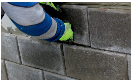
obr.8 - osazení tvarovky na kotvu
