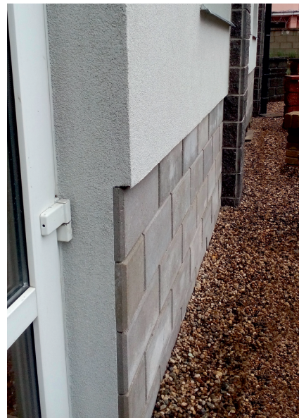
obr.9 - dokončená stěna z obkladových tvarovek PlayBlok
