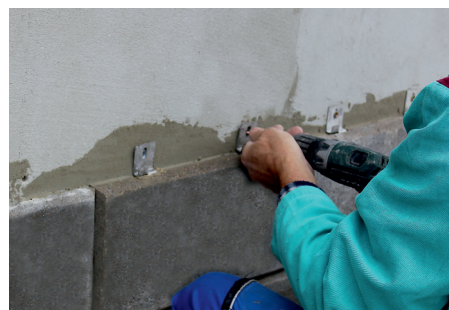
obr.6 - vložení hmoždinky a přivrtání vrtu k podkladu
