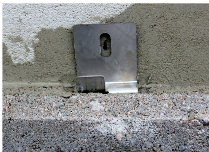
obr.4 - detail vyznačení otvoru pro kotvu
