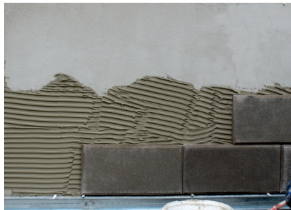
obr.1 - nanesení lepidla
