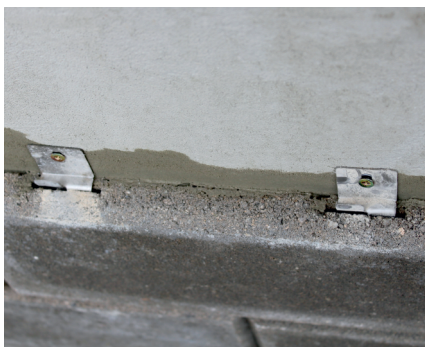
obr.7 - detail kotvení tvarovky k podkladu
