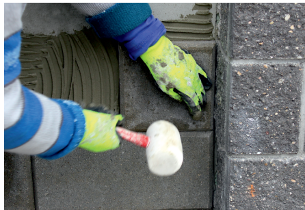
obr.2 - urovnání tvarovky do roviny
