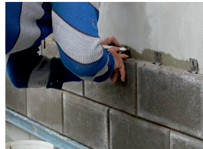
obr.3 - vyznačení otvoru pro kotvu
