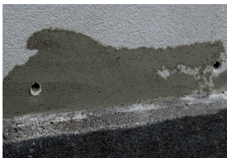
obr.5 - vyrvané a očištěné otvory pro kotvení
